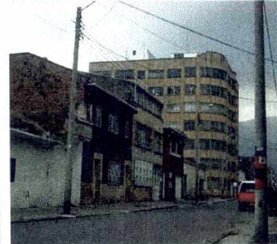
ALTERACIONES A LA EDIFICACION ORIGINAL VISIBLES DESDE EL EXTERIOR :
